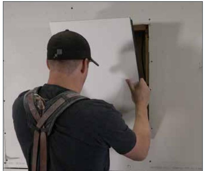
12. スピーカーの振動板の中心（凹んだエッジではない）が周囲の乾式壁と同じ高さにあることを確認してください。必要であればシムを調整します。
