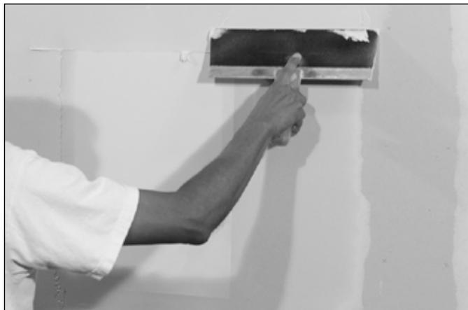
12. コンパウンド細部の工具跡を最小限に抑えるようにします。
