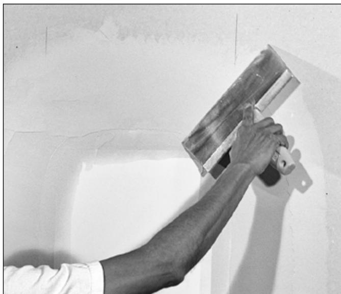
7. ホットマッドが完全に硬化したら、遅硬化性コンパウンドで目地を覆います。
