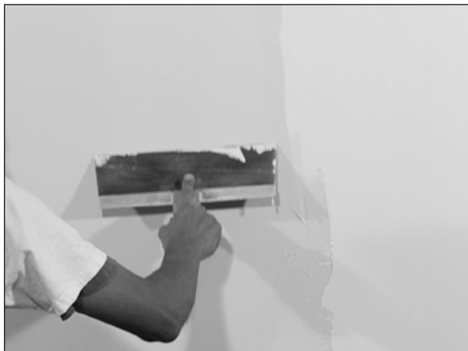
15. 最終塗装が終わり乾燥したら、手動ポールサンダーまたはブロックサンダーで壁全体を研磨します（スピーカーの表面を傷つける恐れがあるため、電動サンダーは使用しないでください）
