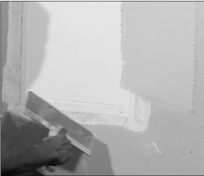
注：スピーカー表面のカバーには、硬化の早い乾式壁用コンパウンド（ホットマッド）は使用しないでください。（柔軟性に欠けるため、ISスピーカーの耐久性を高めることはできません）
